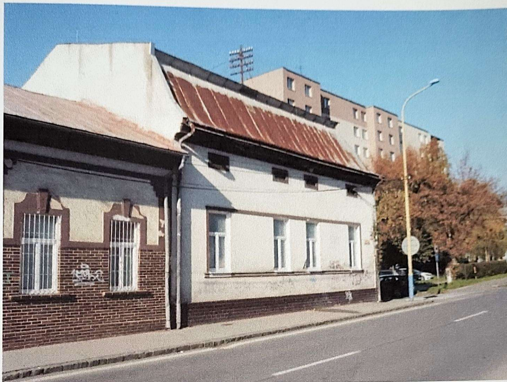
Budova č.s. 1514 na parc. KN 3775 – pohľad juhovýchodný
